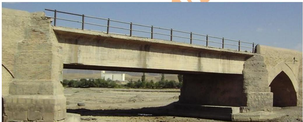
نمایی از مرمت دو دهنه از ۲۳ پل میانه که به یک دهنه تبدیل شده است!
